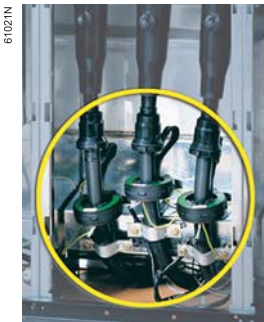
Cảm biến dòng dạng kẹp
